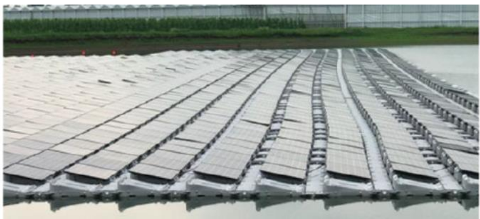
Standaard, dichte zonnepanelen met blokkade van licht en lucht naar het water.
